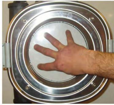
▶ Gleichmässig auf die Isolierung drücken, um diese bis Anschlag in den Feuerraum zu bringen,
