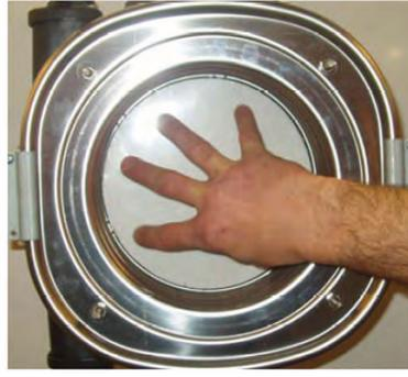
► Appuyer uniformément sur l'isolation, pour la placer en butée au fond du foyer,
