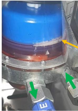
Bulles d'air = **entrée d'air** sur l'installation fioul
